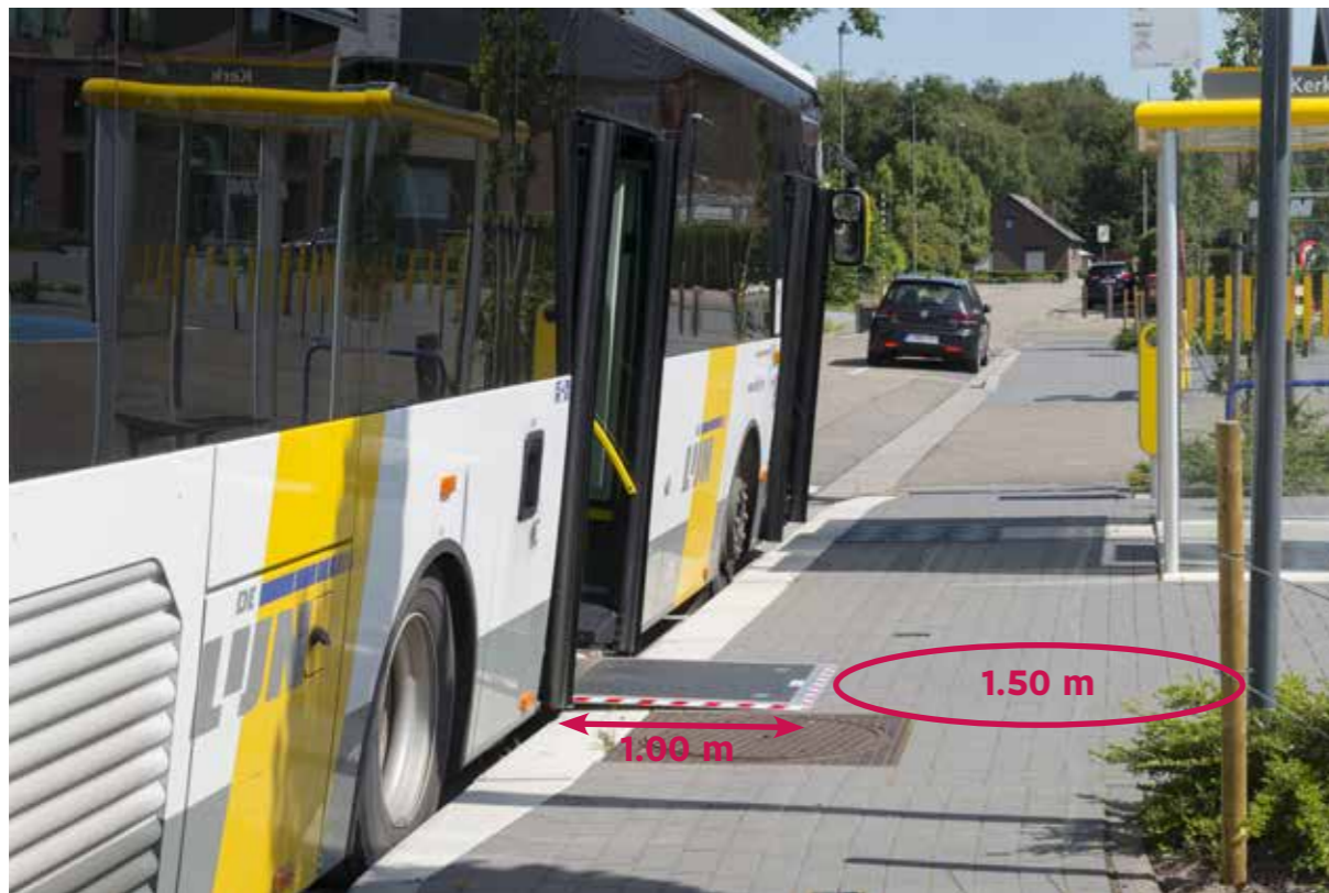
Benodigde breedte ter hoogte van rolstoeltoegankelijke deur: Oprijplaat 1,00 m + draaicirkel rolstoel 1,50 m = 2,50 m.
