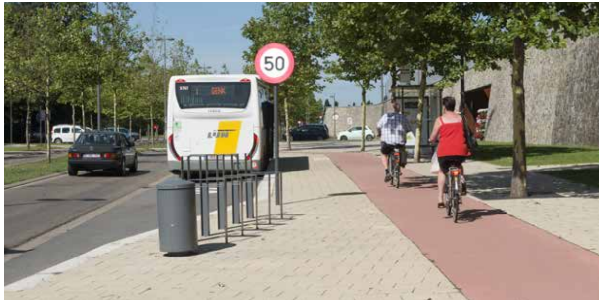
Correct aangelegd fietspad op dezelfde hoogte van het perron waarbij de afstand tussen het fietspad en de perronboord groter is dan 1 m.
