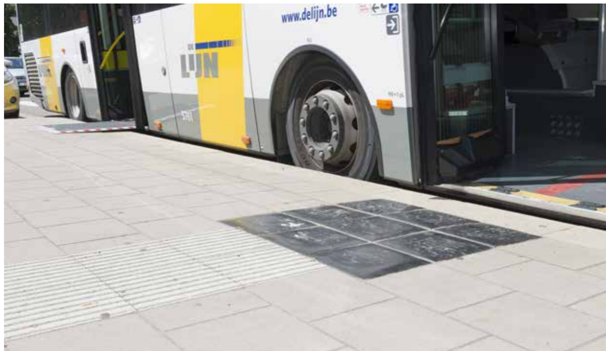
Het rubberen opstapvlak van 90cm op 90cm met de aansluitende geleidelijn in ribbeltegels/markering tot aan de natuurlijke gidslijn.
