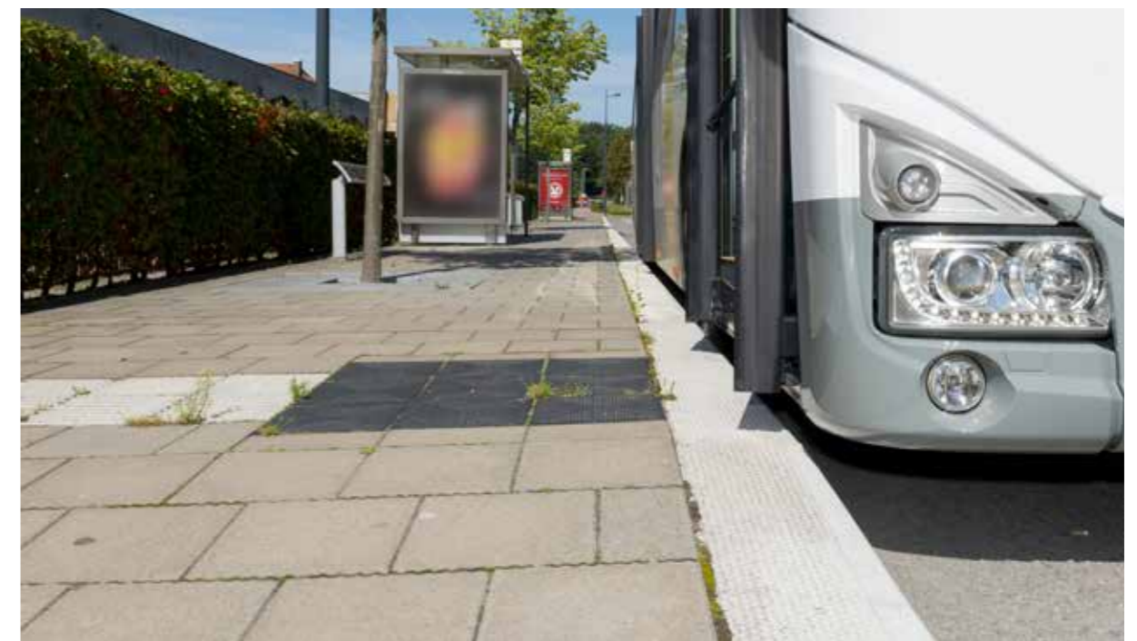
Effen verharding met beperkte dwarshelling. De aanrijdbare boordsteen en perronrand zorgen ervoor dat de halte duidelijk herkenbaar is. Het rubberen opstapvlak duidt aan waar de bus zal stoppen.
